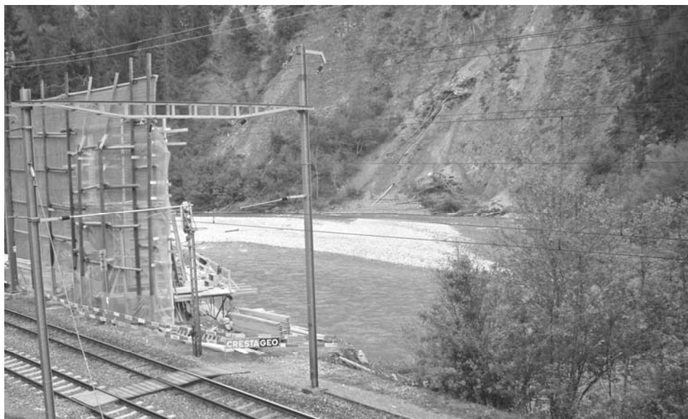
Hier bei der RhB-Station Trin entsteht ein Fussgängersteg als Bestandteil eines durchgehenden Wanderweges durch die Ruinaulta (Foto Harald Keller 15.05.2010)
